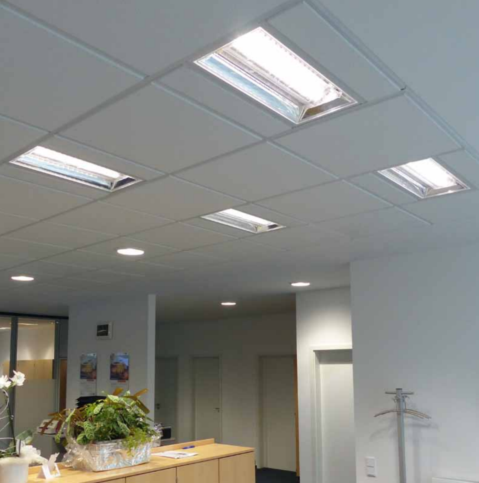
Reflektor metallisiert, Lichtscheibe klar
